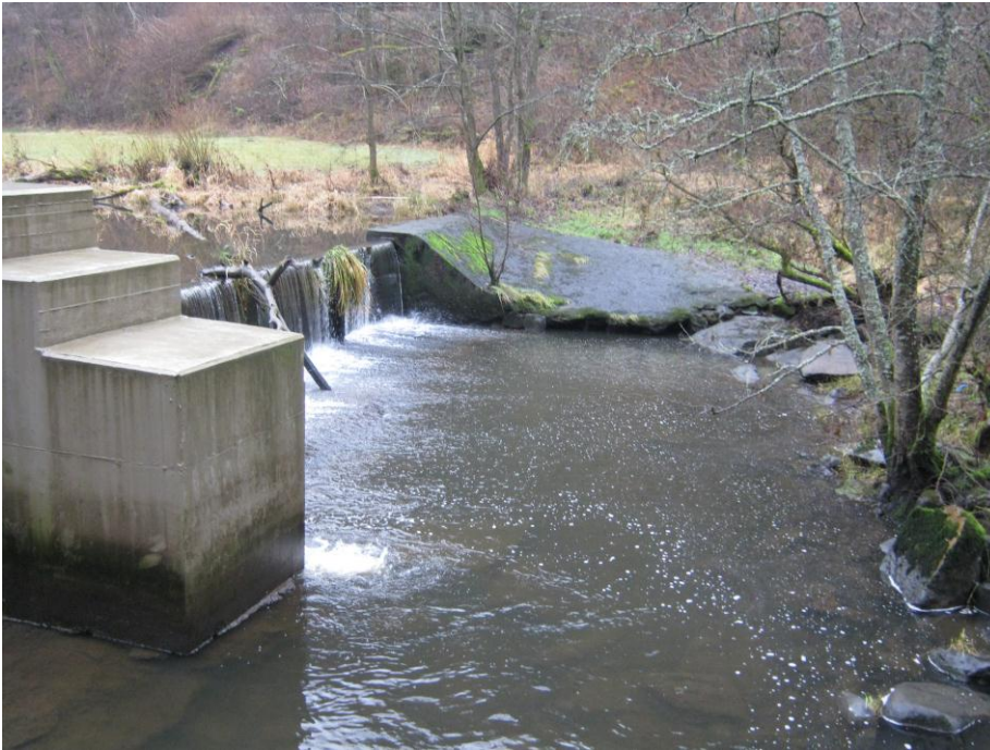
Foto 7: Wehr der Wasserkraftanlage Vormurnthal ohne Fischwanderhilfe, neben dem Betonsockel wird eine Restwassermenge über eine Rohrleitung abgegeben.
