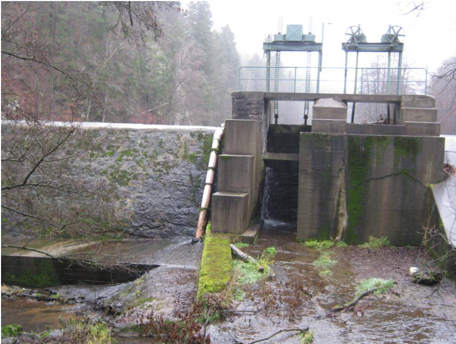
Foto 5: Wehranlage der Wasserkraftanlage Obermurnthal, ohne Fischwanderhilfe, Abgabe einer Restwassermenge über Rohrleitung
