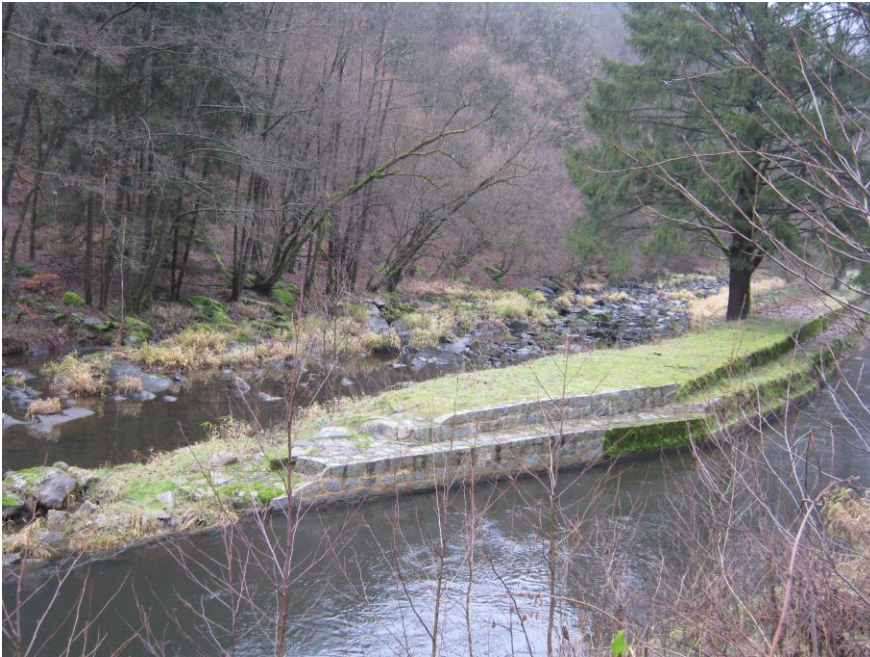
Foto 3: Unterwasserkanal der Wasserkraftanlage Untermurnthal und im Hintergrund Altbett der Schwarzach ohne ausreichende Restwassermenge
