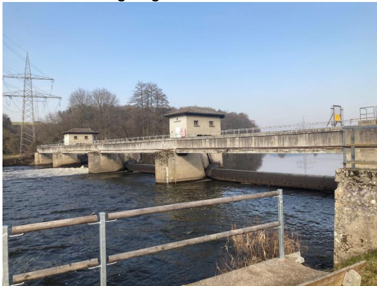
Wehr mit festgelegtem Stauziel
