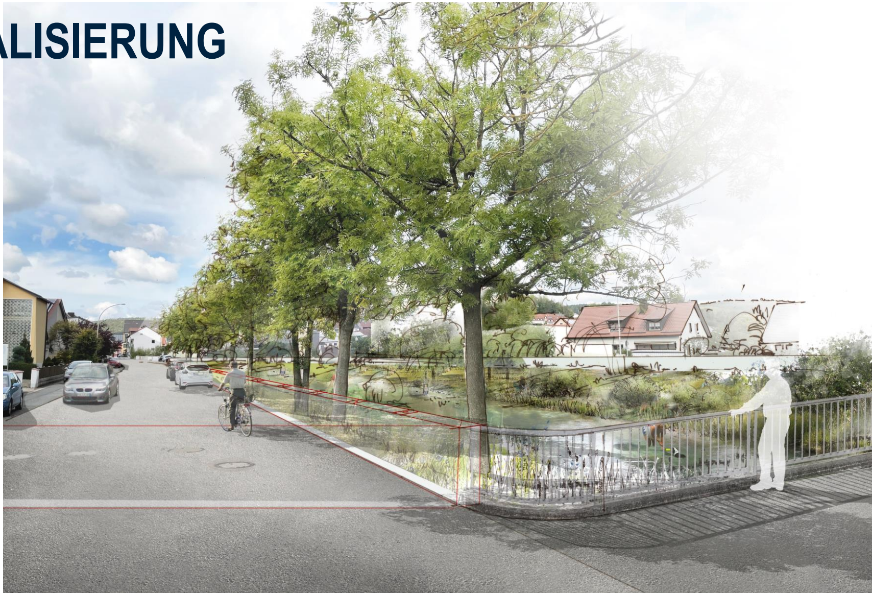
Ansicht entlang der Sportplatzstraße entgegen der Fließrichtung des Schilternbach, Bildmitte: ortsfeste Wand mit Befestigungen für mobilen HWS, rechts im Bild: neu zu errichtende Brücke Visualisierung: die Grille
